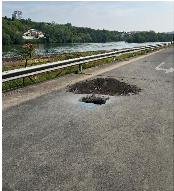
*Sécurisation vis-à-vis des réseaux par géoradar et avant-trous*
