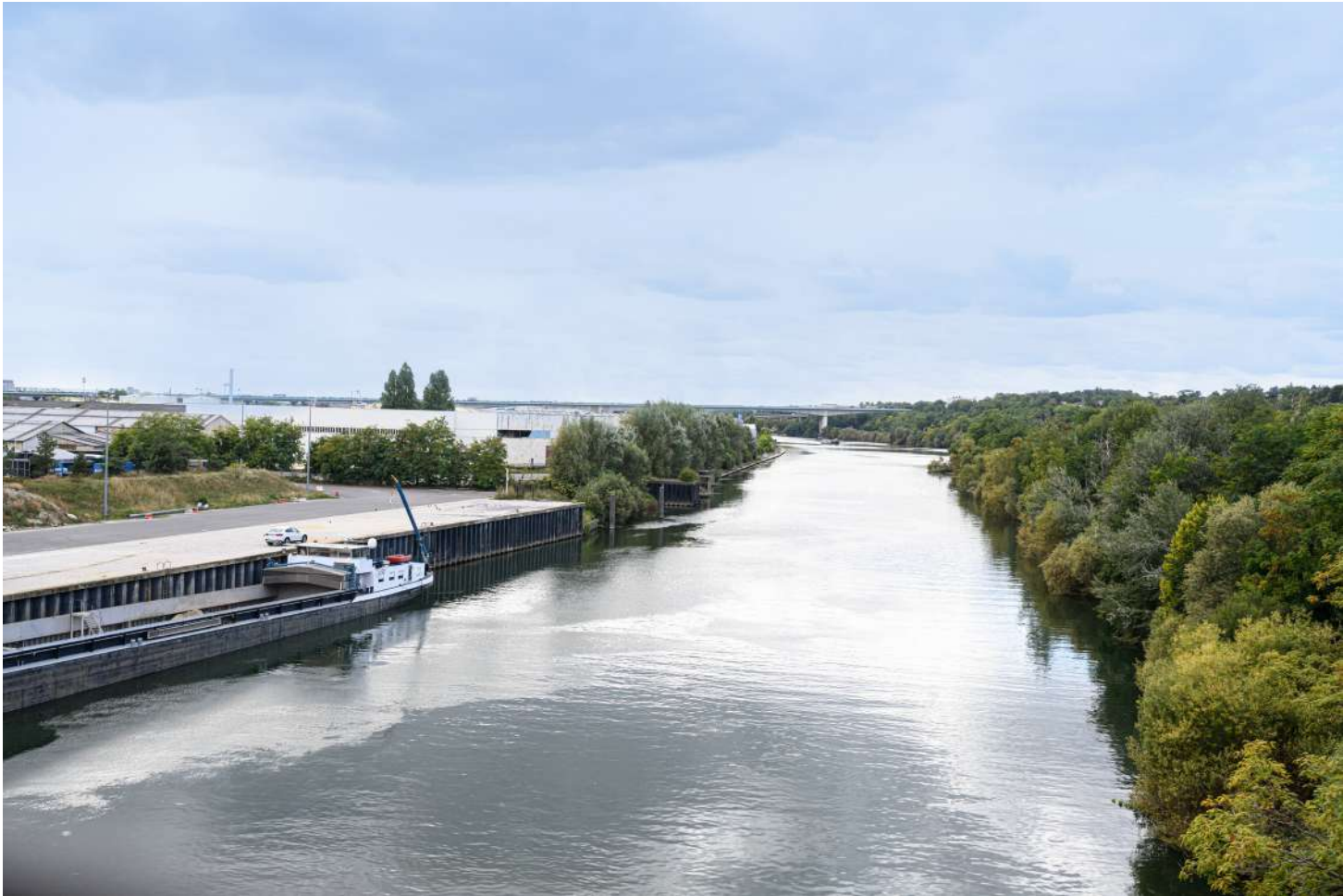
ÉTAT ACTUEL (AVANT DÉMOLITION)
