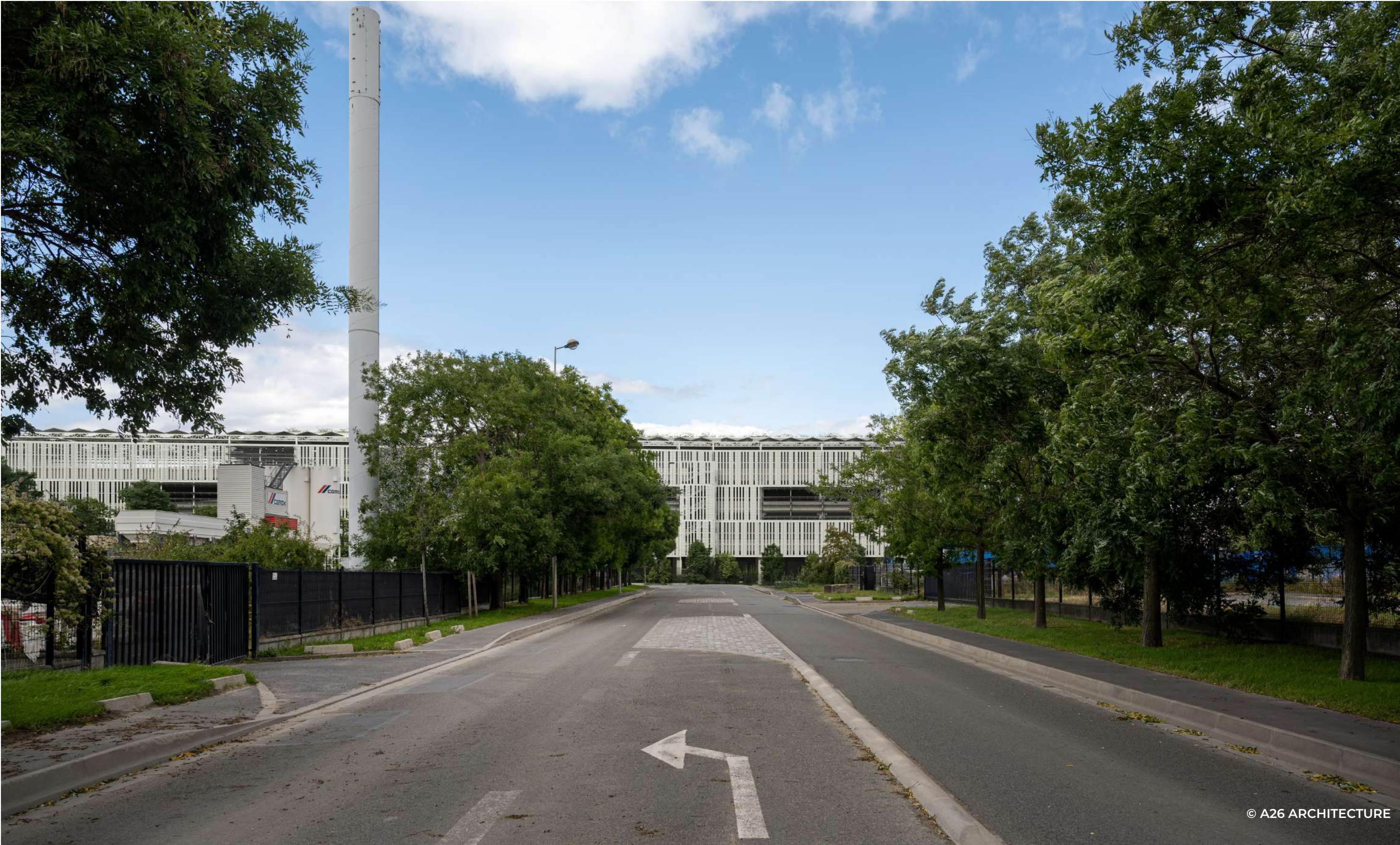
Vue Sud depuis la route du Bassin Numéro 6 à Gennevilliers
