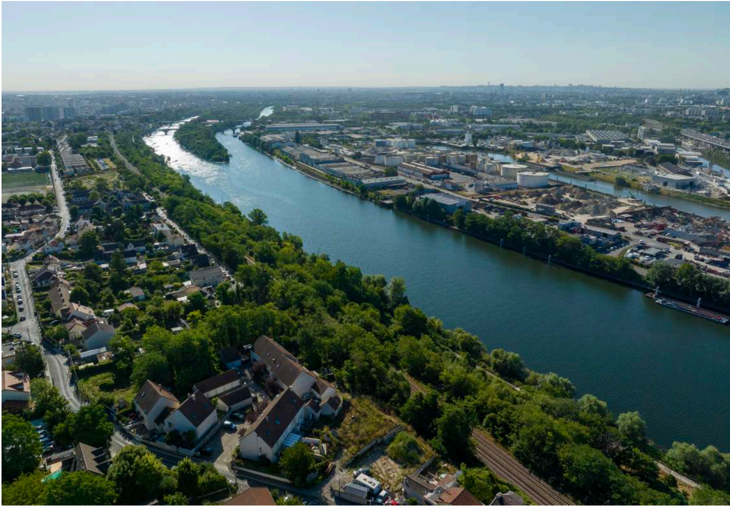
ÉTAT ACTUEL (AVANT DÉMOLITION)
