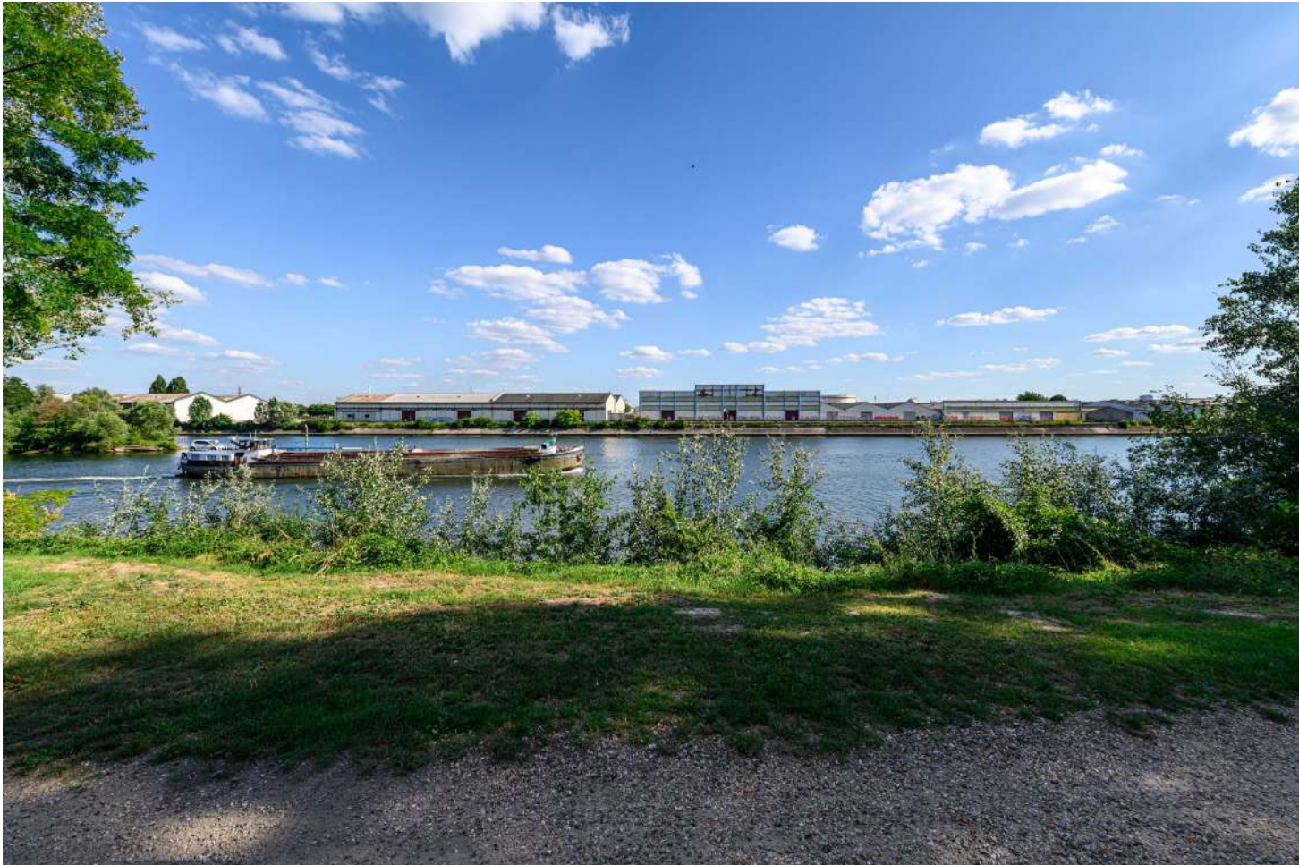
ÉTAT ACTUEL (AVANT DÉMOLITION)
