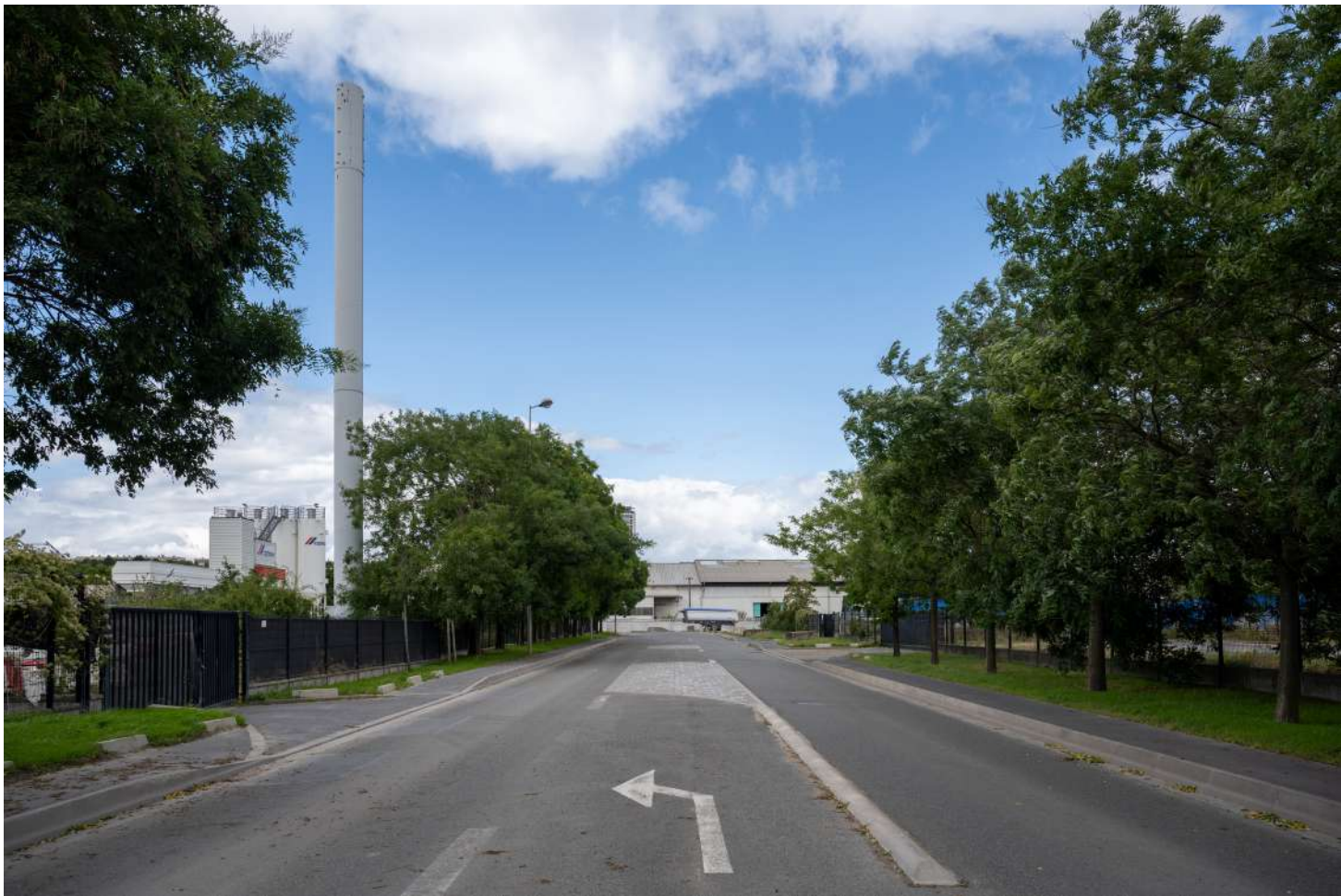
ÉTAT ACTUEL (AVANT DÉMOLITION)
