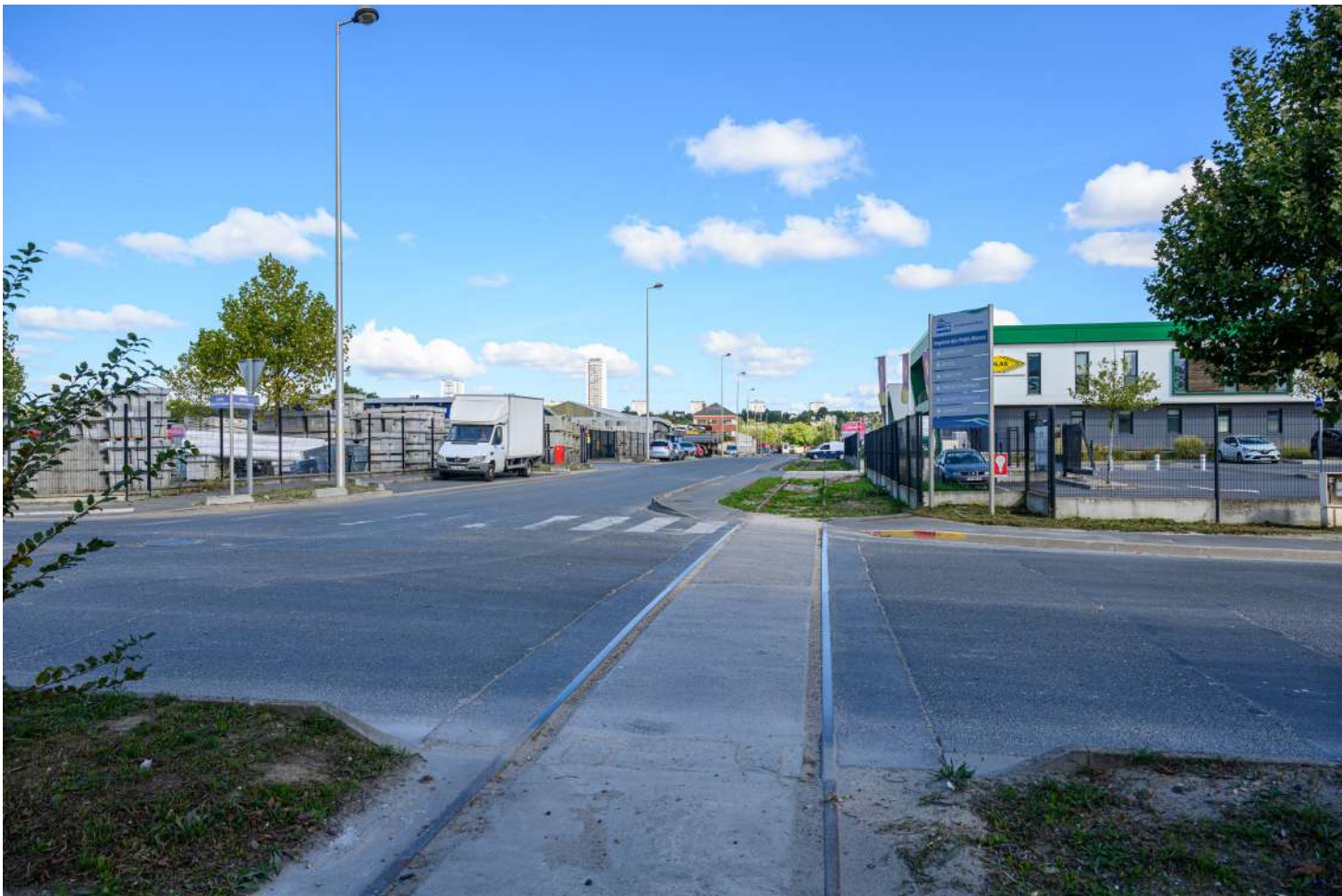
ÉTAT ACTUEL (AVANT DÉMOLITION)
