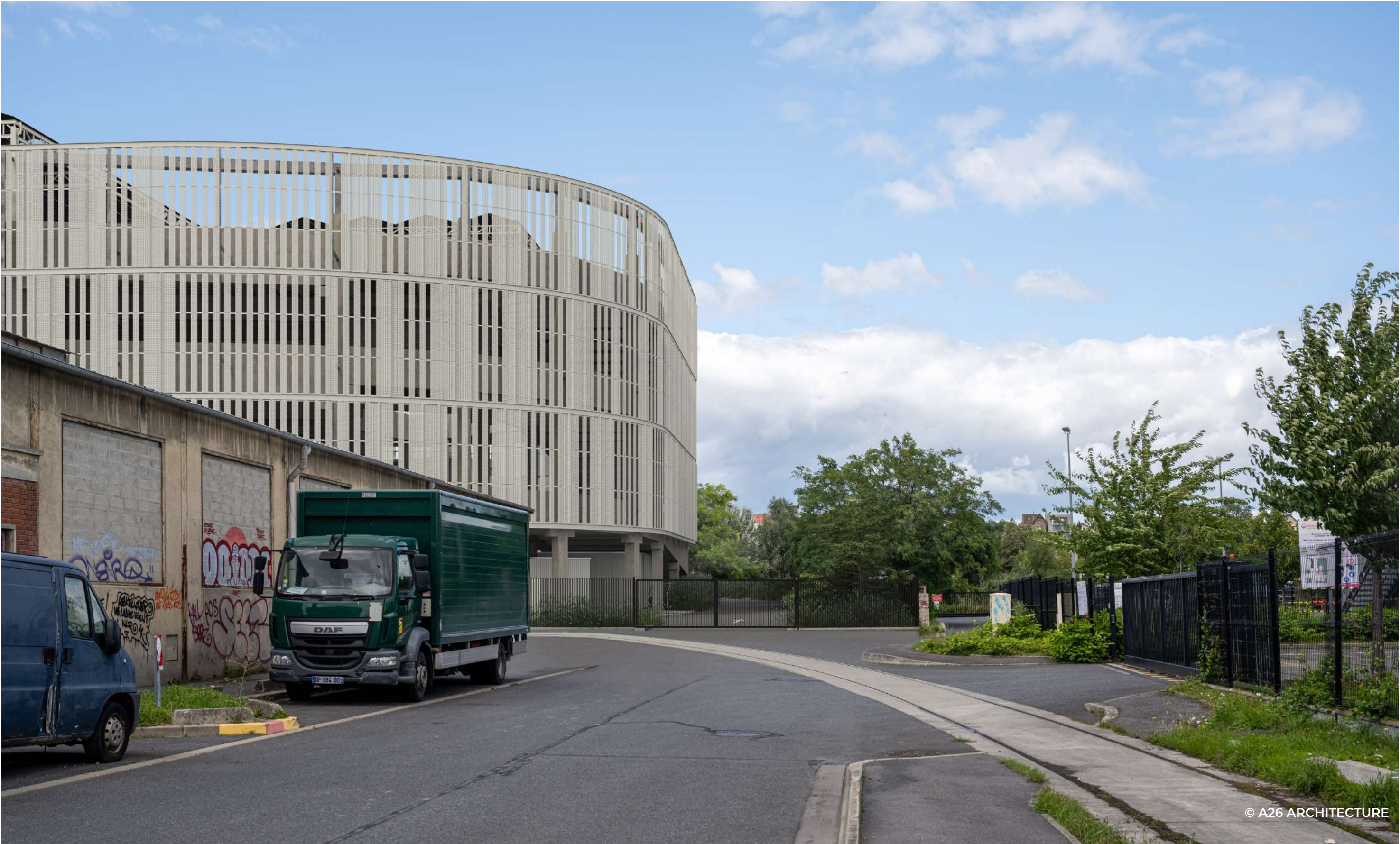
Vue de l'accès au projet vers l'Impasse des Petits Marais à Gennevilliers
