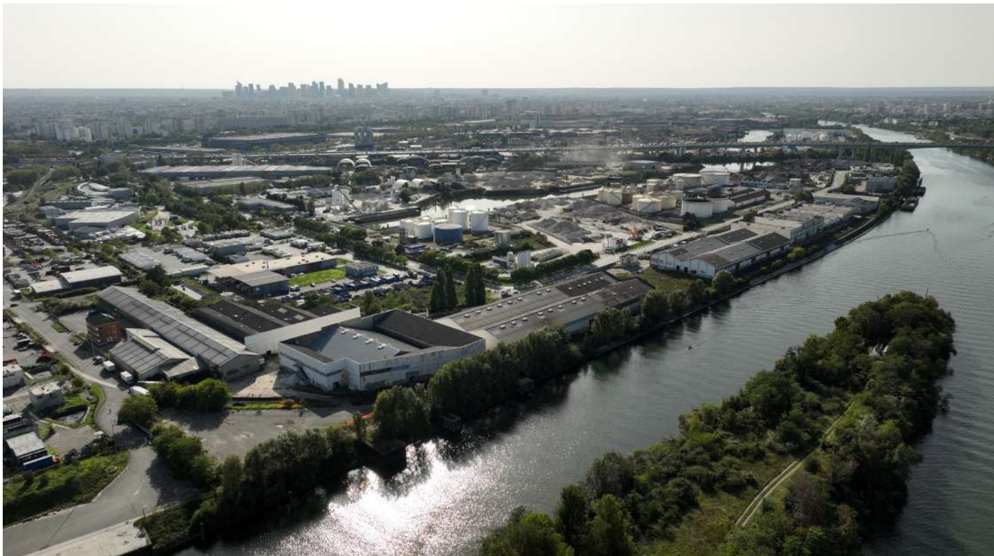
ÉTAT ACTUEL (AVANT DÉMOLITION)
