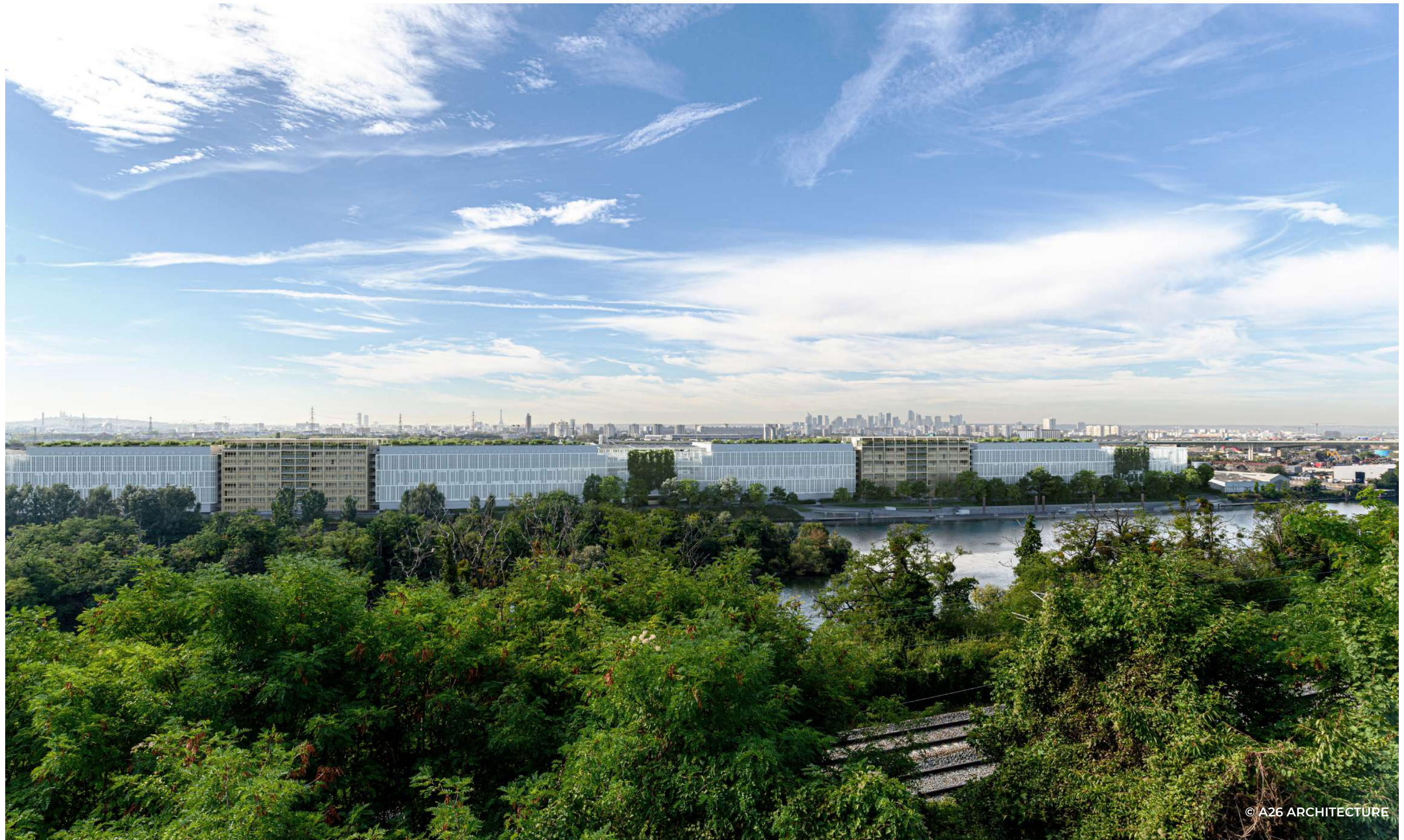
Vue depuis la toiture du Pôle Musical d'Épinay-sur-Seine
