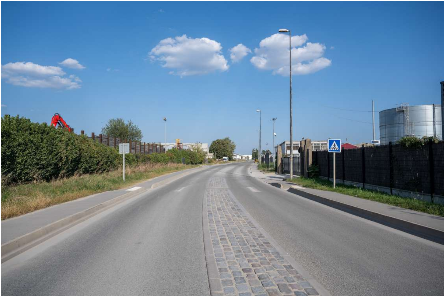
ÉTAT ACTUEL (AVANT DÉMOLITION)
