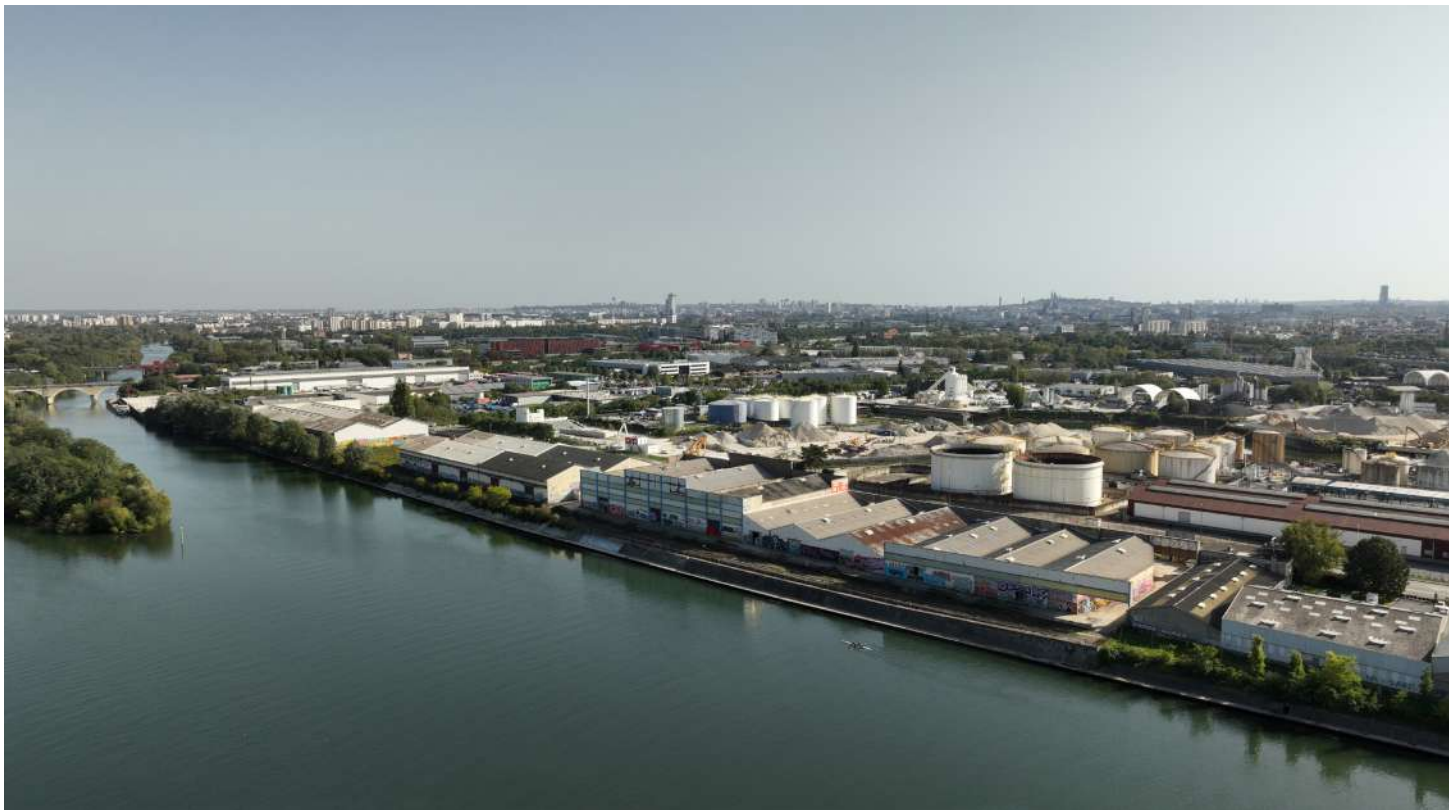
ÉTAT ACTUEL (AVANT DÉMOLITION)
