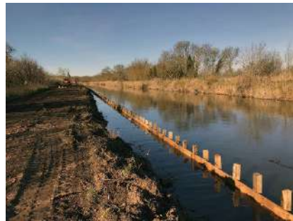
Photo 10 – Mise en place des pieux et des planches - © Dynamique Environnement
