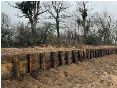
Photo 11 – Principe de stabilisation du tunage utilisé ici en tenue de berge - © Dynamique Environnement
