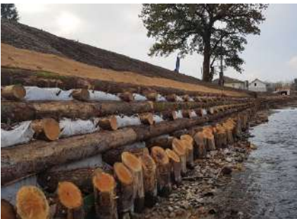
Photo 15 – Réhausse d'une berge avec système de caisson végétalisé © La Compagnie des forestier
