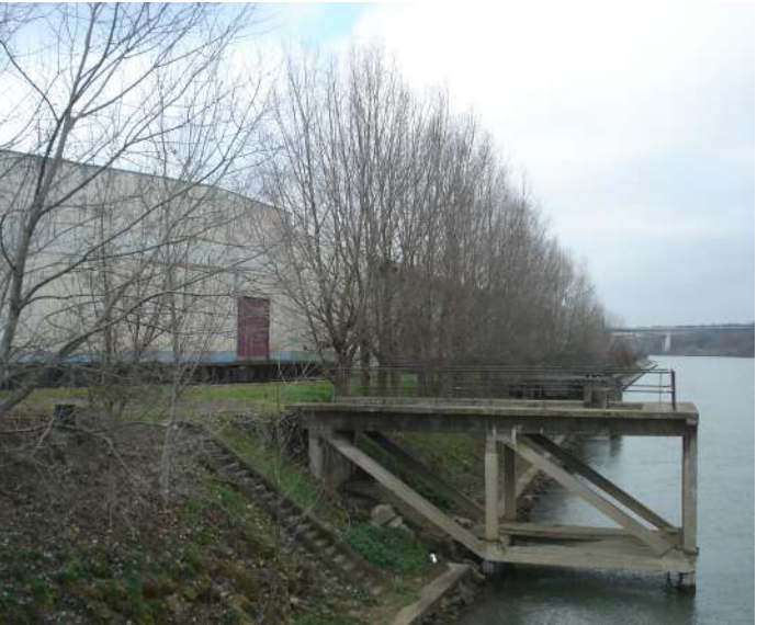
Figure 10 : Photo du terrain avant démolition - un des trois pontons existants conservés
