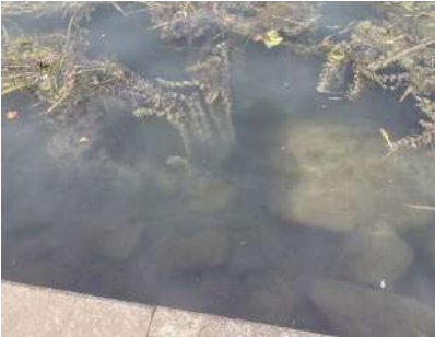
Photo 9 – Secteur du perré béton - Myriophylle en bord de berge
