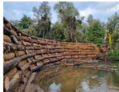
Photo 16 – Possibilité de réaliser de grandes hauteurs de soutènement. © Dynamique Environnement
