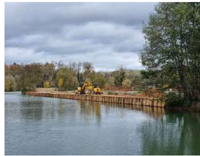
Photo 12 – Exemple de tunage en tenue de berge - © Dynamique Environnement
