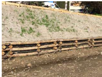
Photo 14 – Réhausse d'une berge avec système de caisson végétalisé - © GTP
