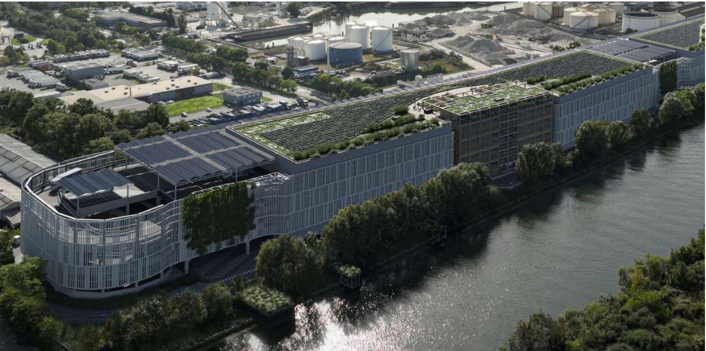
Figure 48 : Extrait de la vue drone prise au-dessus de l'Île-Saint-Denis, entre Epinay-sur-Seine et Gennevilliers - rampe Ouest
