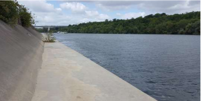
Figure 11 : Photo du terrain dans son état initial - perré béton
