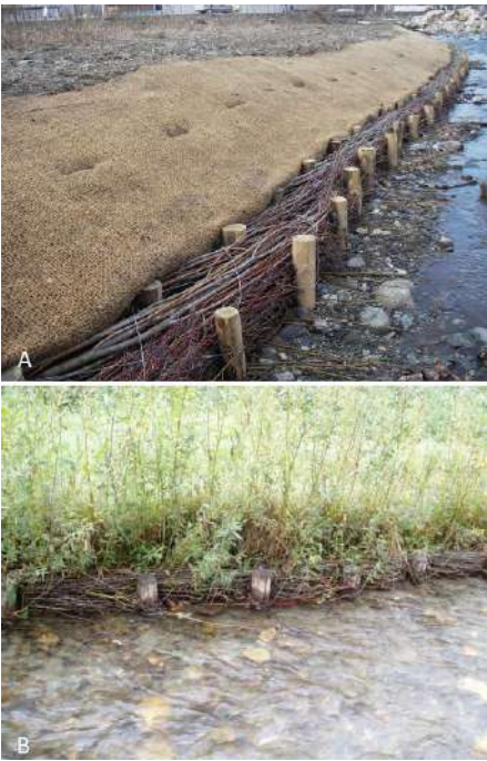
Photo 13 – Fascine de pied de berge (A) © Belleudy et durant la saison de végétation après la mise en œuvre © André Evette – Guide INRAE / OFB
