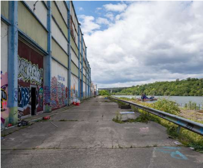
Figure 9 : Photo du terrain avant démolition - plateforme bétonnée et bâtiments existants
