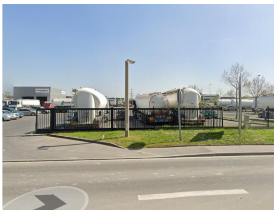
Caméra orientée vers l'accès sécurisé.
