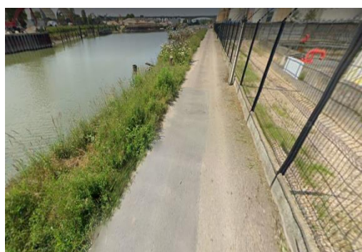
Voie secours depuis le 34 route de bassins 2
