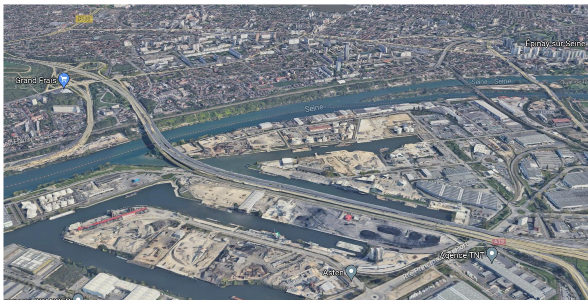
Vue aérienne sud nord
