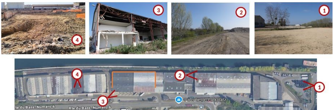
Illustration 5- Le site du projet le 27 mars 2025 (photos MRAe). Encadré en orange, le seul bâti non entièrement démoli pour que le concassage des débris se fasse derrière la façade faisant office de mur anti-bruit. Ce point n'a pu être constaté en absence de travaux lors de la visite. Hormis les bâtis « orange », la végétation devant ceux-ci, un tas de blocs concassés (photo n°2 au fond), quelques soubassements et la végétation sur l'extrême bord de la berge, le terrain est complètement à nu. Sur la photo n°2, on distingue des barrières anti-intrusion le long de la berge.
